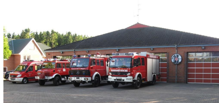
Abbildung 32: Feuerwehrgerätehaus Rickling (FREIWILLIGE FEUERWEHR RICKLING O. J.)
