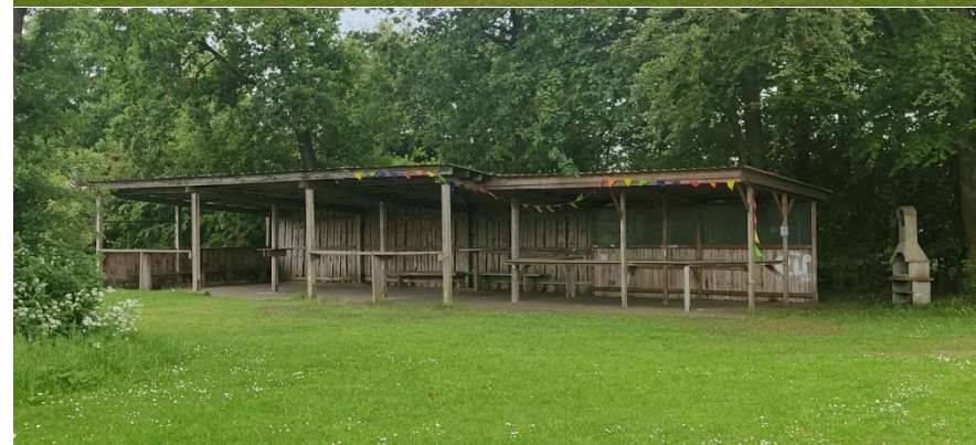
Abbildung 29: Bolzplatz Fehrenbötel mit dahinterliegendem Basketballkorb // Unterstand am Bolzplatz Fehrenbötel (CIMA 2024)
