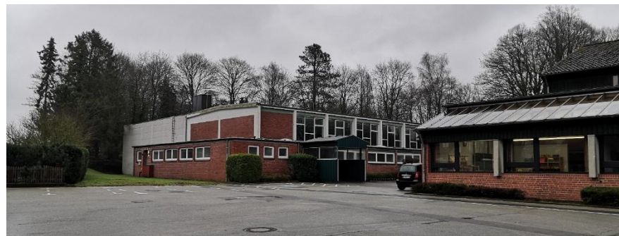
Abbildung 65: Blick auf die Turn- und Sporthalle (CIMA 2024)
