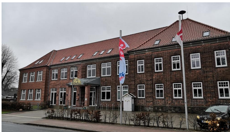
Abbildung 24: Alte Schule Rickling (CIMA 2024)
