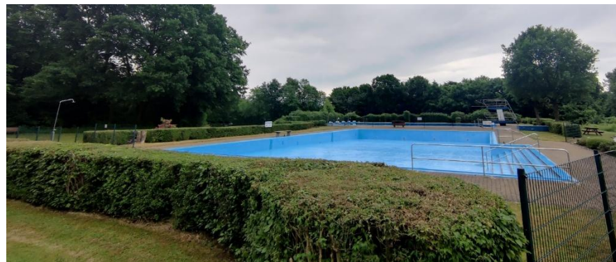
Abbildung 22: Schwimmerbecken im Freibad Rickling (CIMA 2024)
